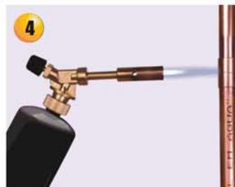
4 - Aplique a chama sobre a conexão para aquecer o tubo e a bolsa da conexão, até que a solda derreta quando colocada na união do tubo com a conexão.
