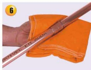
6 - Remova imediatamente o excesso de solda e pasta com um pano seco enquanto a solda ainda permitir, deixando um filete em volta da união.
