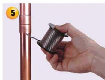
5 - Retire a chama e alimente com solda sem chumbo Eluma (97% Sn x 3% Cu), um ou dois pontos, até ver a solda correr em volta da união. A quantidade correta de solda é aproximadamente igual ao diâmetro da conexão: 28mm de solda para uma conexão de 28mm.
